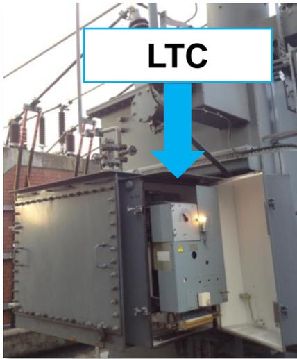
El cambiador de derivaciones puede subir el perfil de tensión del circuito
